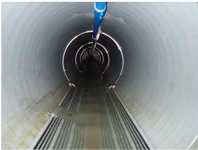
写真-2 下水管内の採熱管敷設状況
