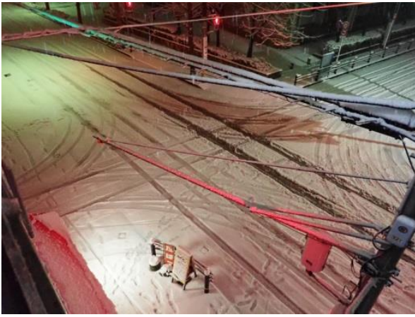
写真-6 放熱条件に合致する路面状況 (性能解析)
